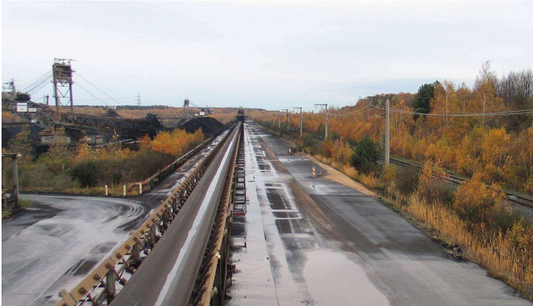
Abb. 5.3/13: Versiegelung unbefestigter Flächen im Kohlebunker
